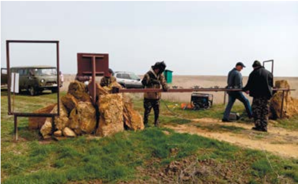
Ремонт информационных анишлагов и входной группы на территории участка Островного. Фото М. Вакуровой
