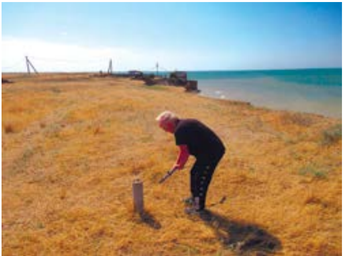
Фото 4. Замер продвижения бровки коренного берега Цимлянского водохранилища в Котельниковском районе Волгоградской области.
