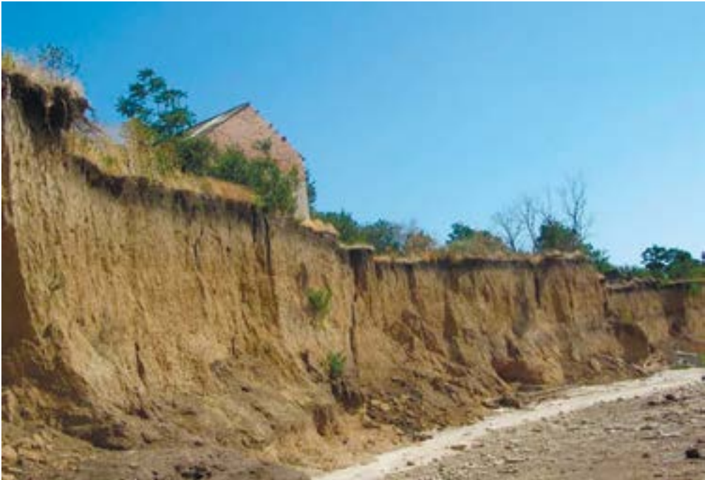
Фото 1.4.2.2. Жилые здания и сооружения располагаются в непосредственной близости к кромке берегового склона, с. Весело-Вознесенка, Неклиновский район Ростовской области (2023 г.).
