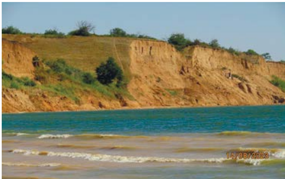
Рис. 2. Общий вид на оползневое проявление. Цимлянский район, северо-восточная окраина г. Цимлянска, 480 м на восток от винзавода.
