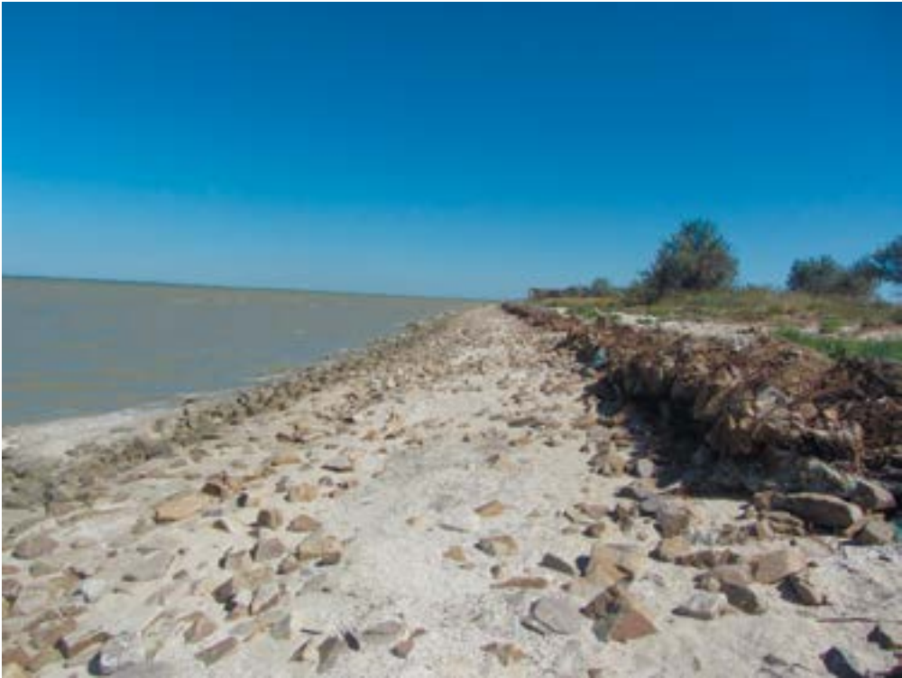
Фото 1.4.2.40. Разрушение габионов.
