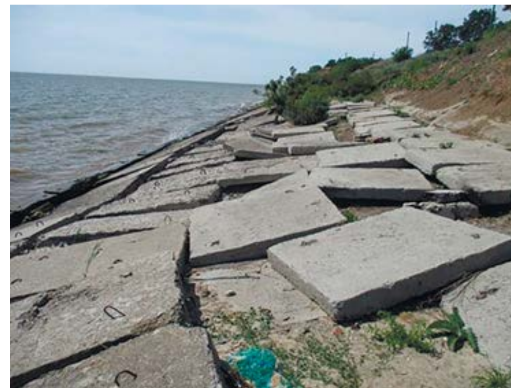
Фото 1.4.2.34. Берегозащитное сооружение в с. Петрушино Ростовской области.
