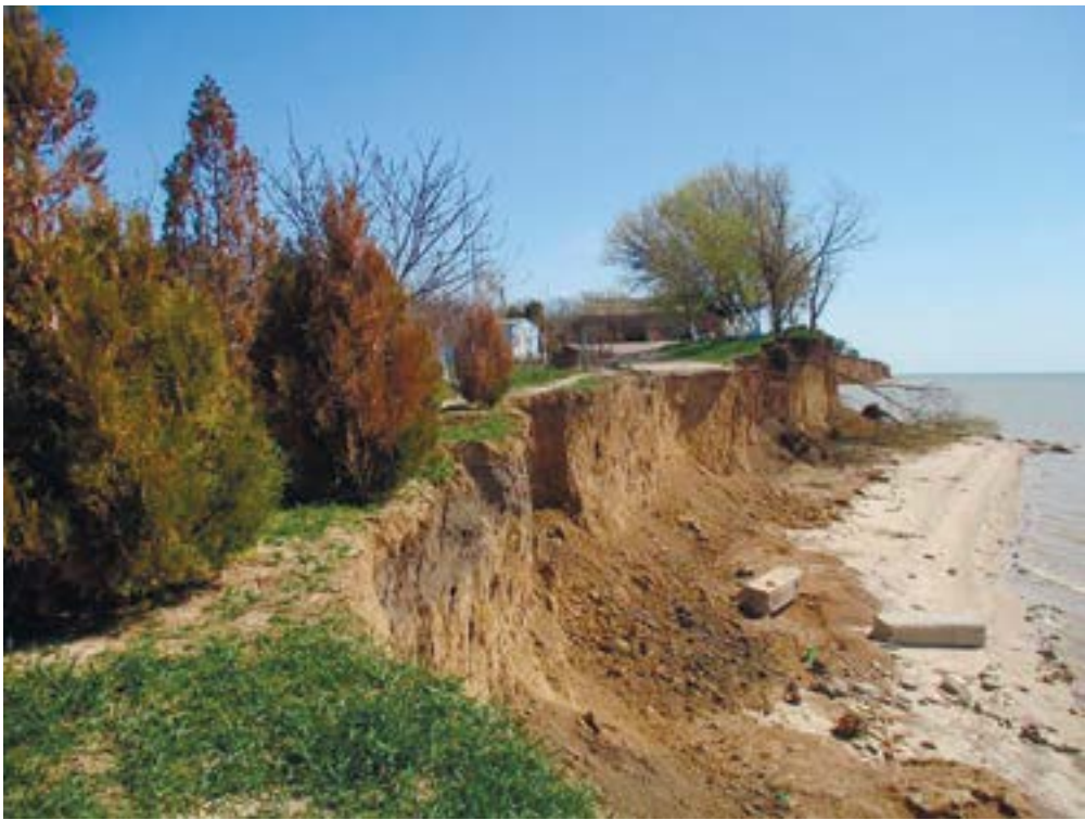
Фото 1.4.2.1. Береговой склон и разрушенная подъездная автомобильная дорога к мосту через реку Мокрый Еланчик, с. Весело-Вознесенка, Неклиновский район Ростовской области.
