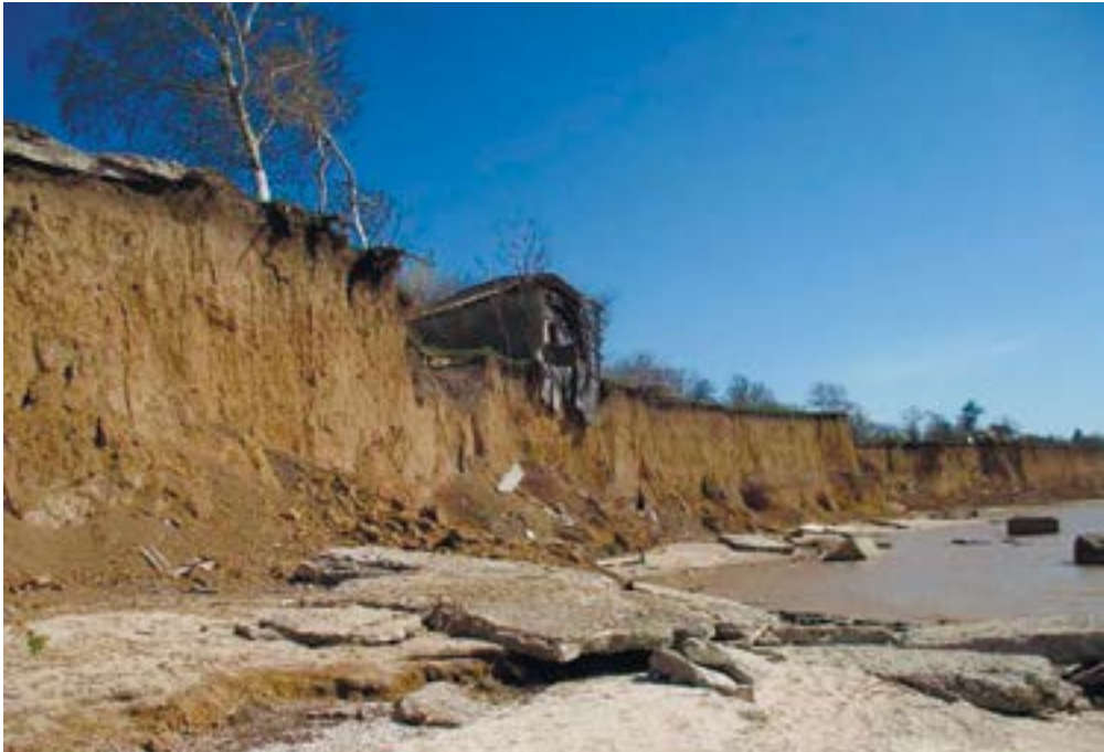
Фото 1.4.2.3. Разрушенное капитальное строение, расположенное на обрыве берегового склона, в районе ул. Береговая, с. Весело-Вознесенка, Неклиновский район Ростовской области (2024 г.).
