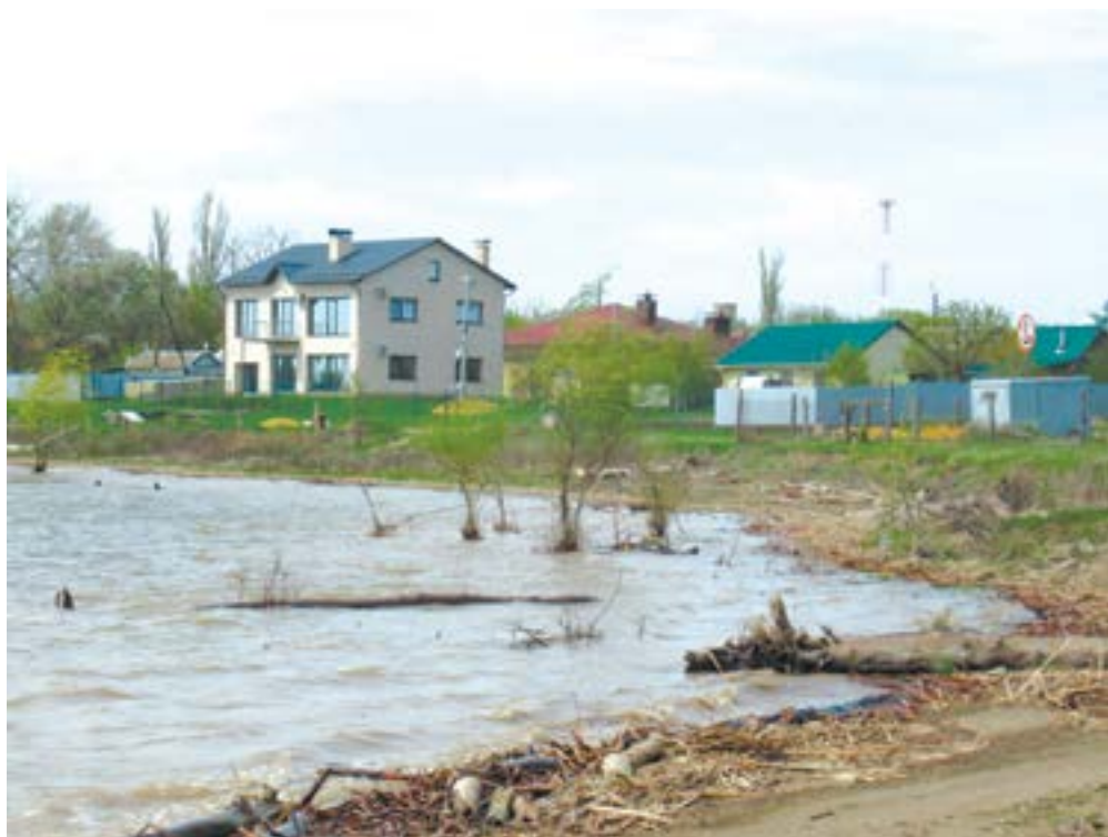
Фото 12. Предпаводковое обследование р. Дон в Калачевском районе Волгоградской области.
