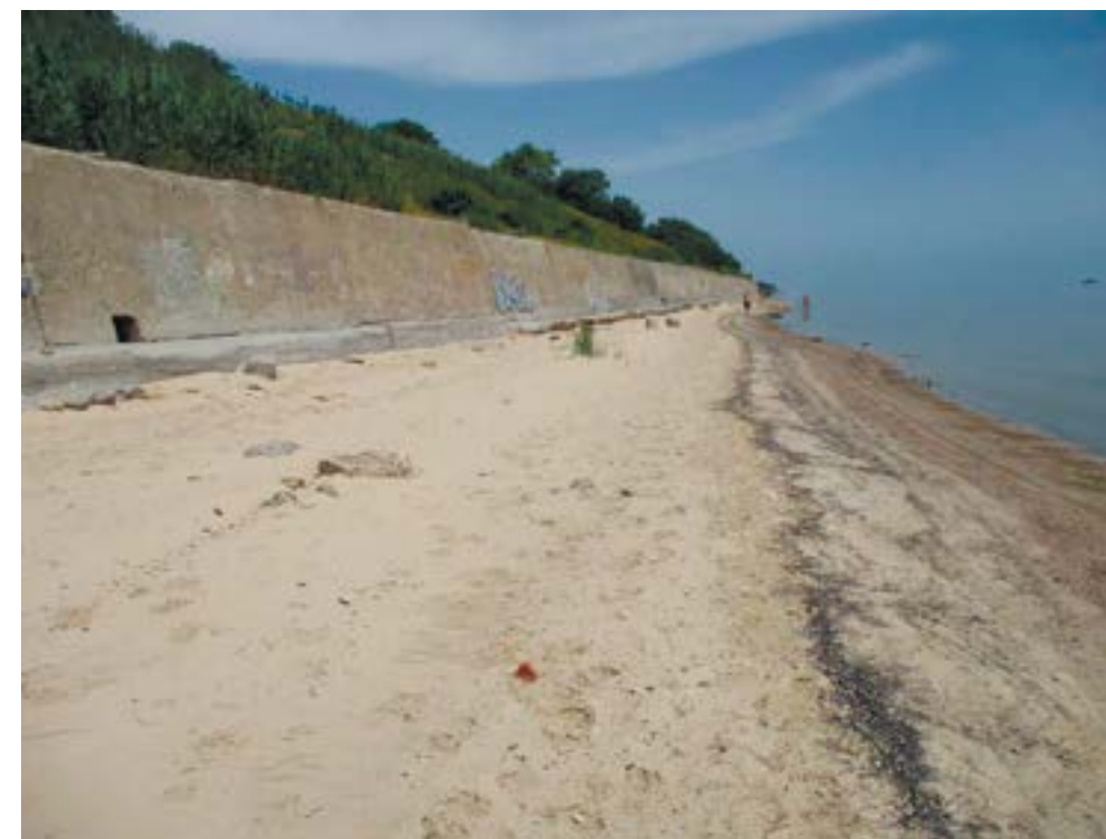
Фото 1.4.2.35. Подпорная стенка бывшей РЖД больницы.
