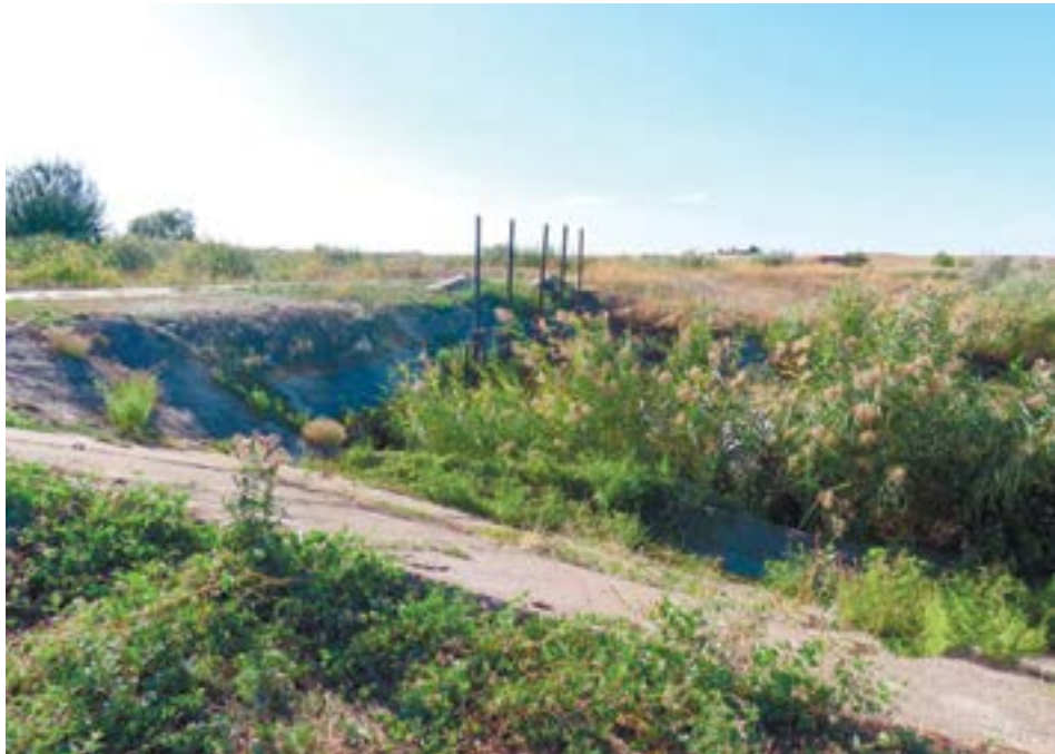
Фото 1. Водопропускное сооружение между западным и восточным отсеками.
