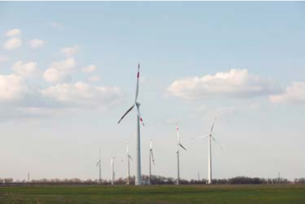
«Марченковская ВЭС» мощностью 120 МВт, Зимовниковский район
